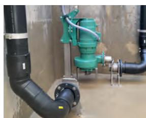
Pressura geschwenkt und abgesenkt in die Position zur Beförderung in die Gülle-Lagerung oder zum Fassfüllen.
