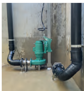
Pressura, Typ Völlmin Absenk- und Schwenkvorrichtung Position für die Umspülung
